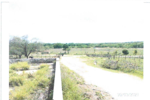
RUA A SER PAVIMENTADA NO SÍTIO PERÍMETRO
