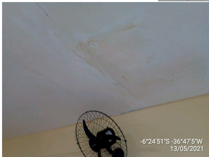
Imagem 43: vista interna da sala de aula 09 (detalhe do forro)
