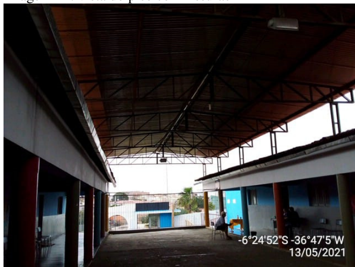
Imagem 22: vista da cobertura
