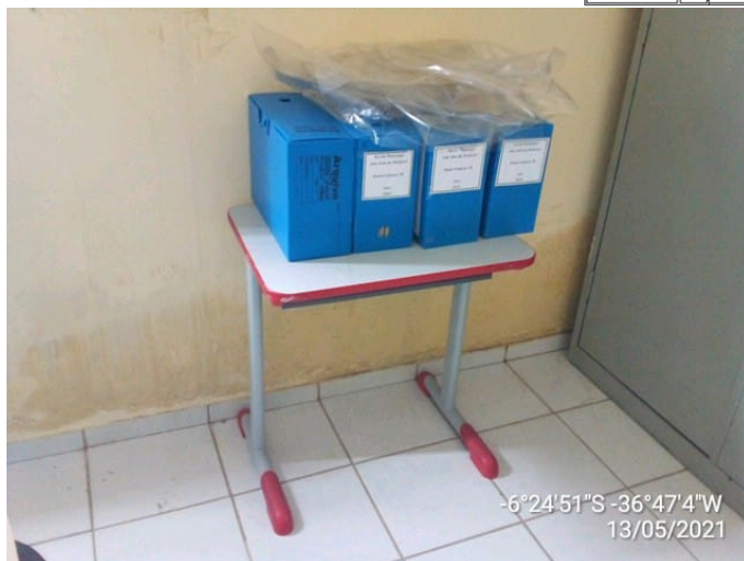
Imagem 03: detalhe de umidade no reboco
