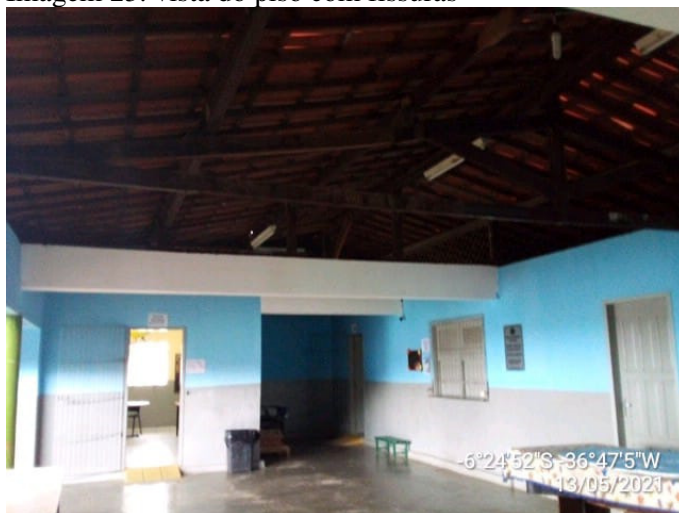
Imagem 24: vista da cobertura
