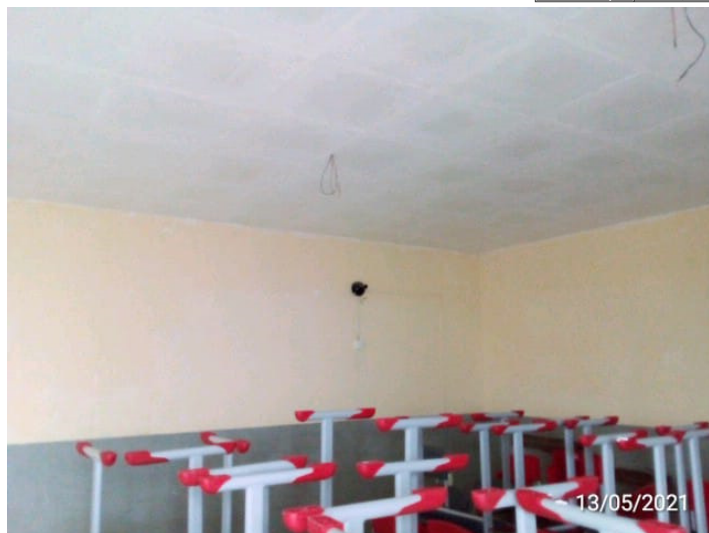
Imagem 41: vista interna da sala de aula 08
